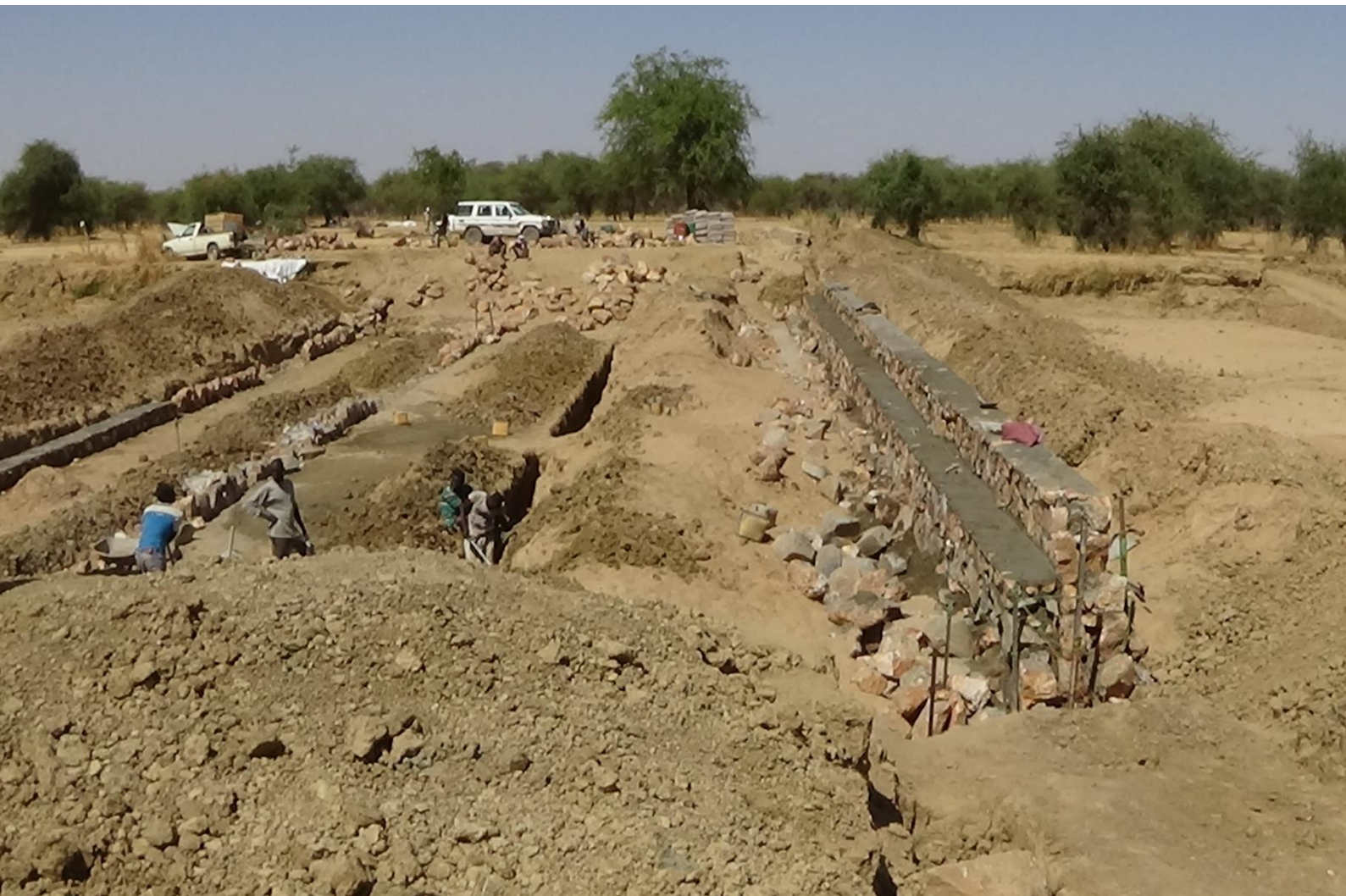
Travaux de construction de seuils dans la vallée de Haradjé (Région du Batha, novembre 2017)
