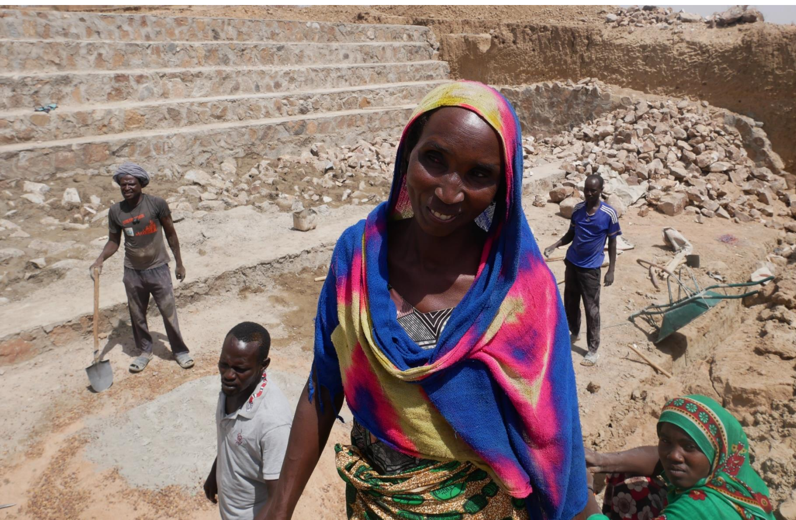
Participation de Mme Fatouma Tom ISSA à la construction des seuils dans la vallée d'Amdabouka, mai 2020
